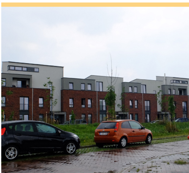
figuur 57 groepswoningbouw . Witzenbergstraat
