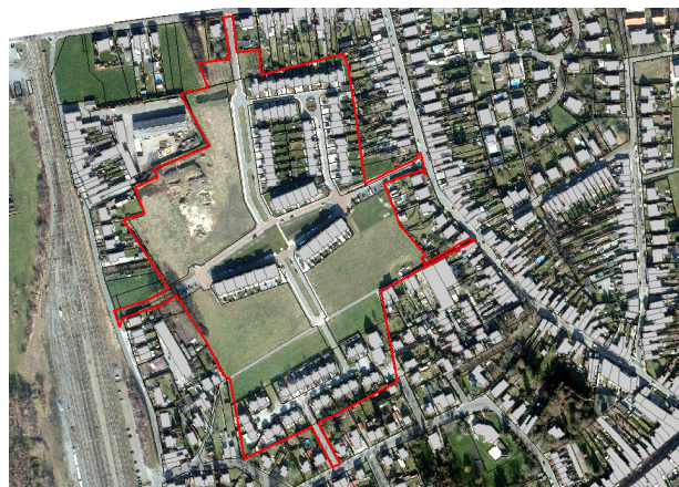
figuur 11 bestaande hoofdgebouwen in het BPA Statievelden (GRB d.d. 1 januari 2020 op orthofoto 2019)
